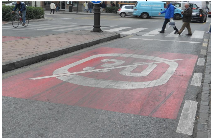
Figura 25. Pintura en asfalto en Calle Acera del Darro. Granada
