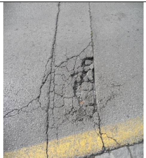
Figura 23. Asfalto en Avda. Constitución. Granada
