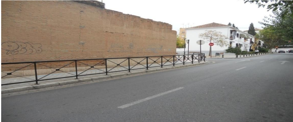
Figura 11. Barandillas en calle antigua cárcel de Granada.
