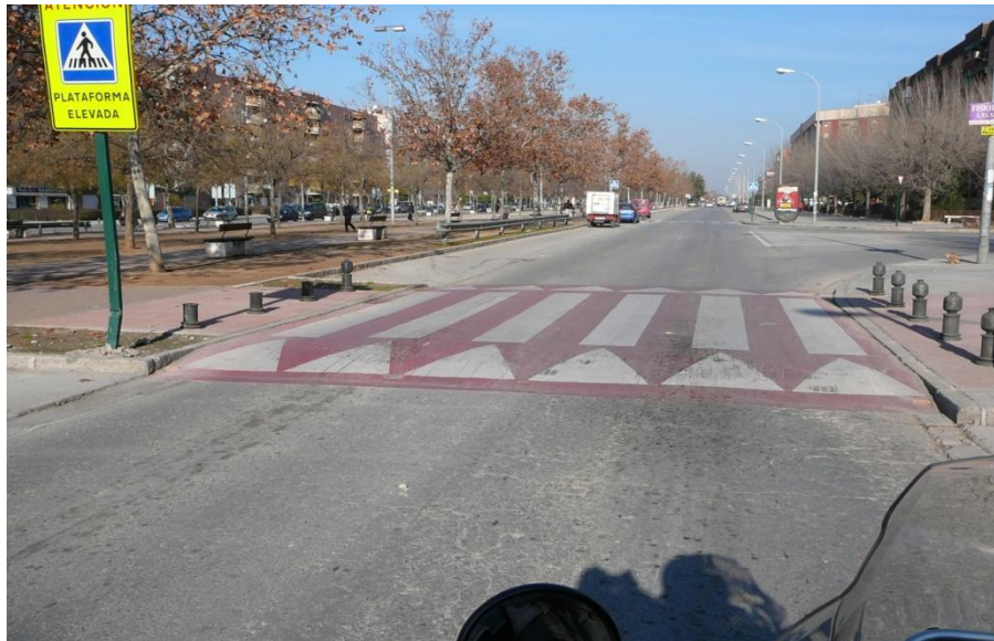
Figura 26. Paso de cebra elevado y con pintura. Calle Joaquina Egvaras. Granada
